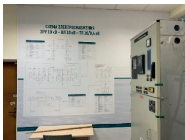
Комплектное распределительное устройство D-12P
