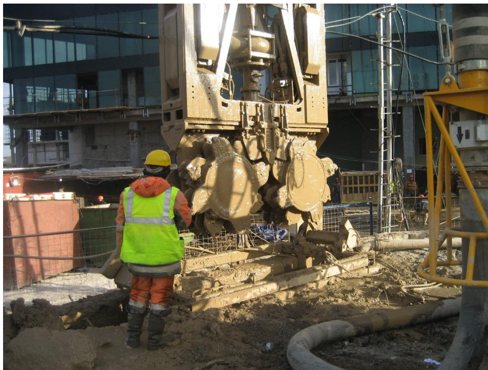
Рис. 2.13. Гидрофреза для откопки «стены в грунте» траншейного типа
