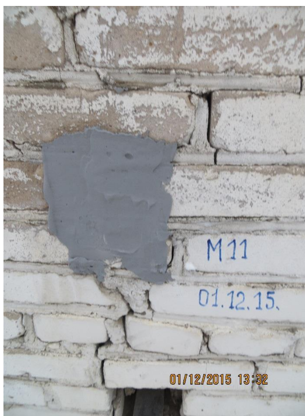
Рис. 1.17. Трещины в несущей стене здания № 2.
