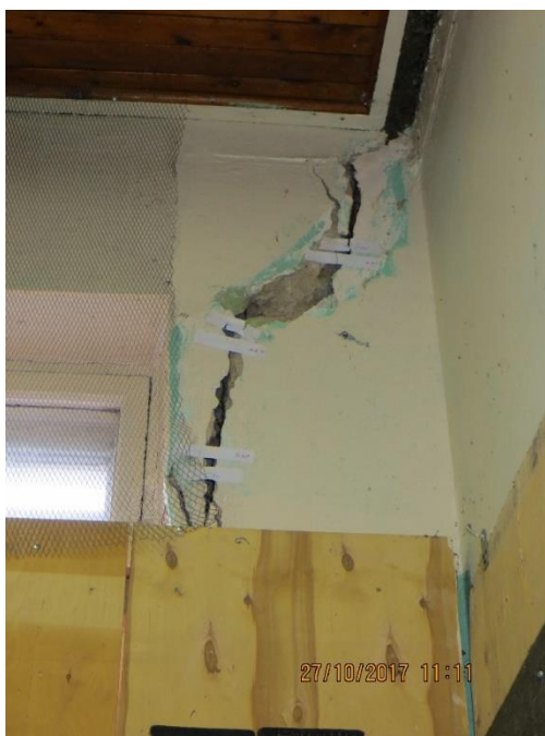
Рис. 5.2. Трещины в кирпичной кладке стен с раскрытием 10 – 40 мм
