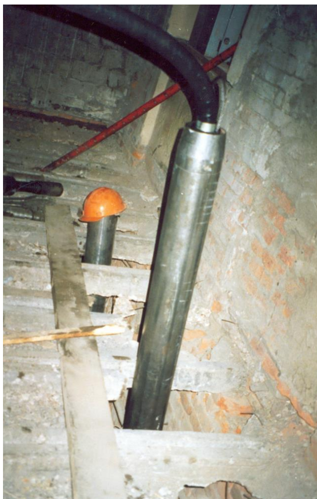
Рис. 2.10. Применение пневмопробойников при усилении фундаментов здания
