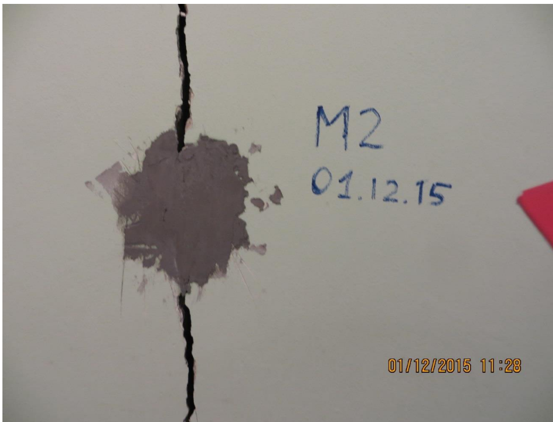
Рис. 1.16. Трещина в несущей стене здания № 1.
