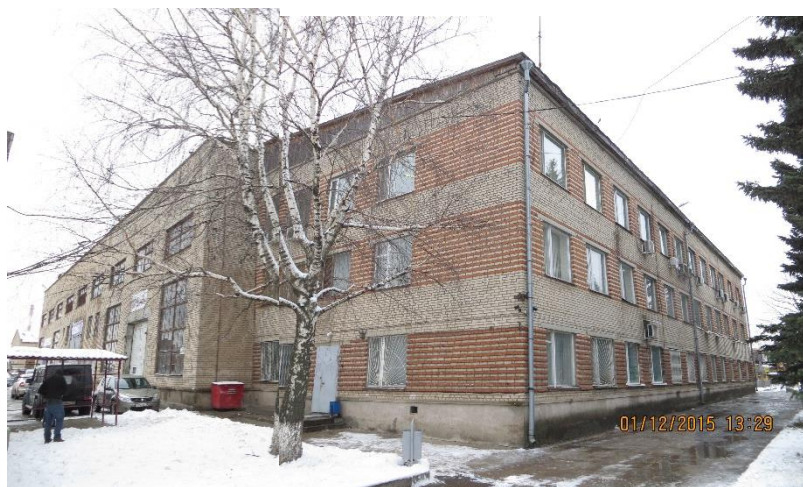
Рис. 1.11. Фрагмент фасада здания № 1, фактическая осадка основания которого превысила 80 мм.
