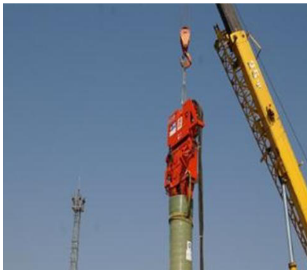
Рисунок 3.6 - Погружение трубошпунта в колонну струйной цементации [124].
