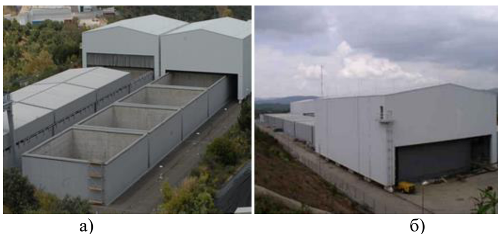
Рисунок 1.12 - Модульное сооружение для низко- и среднеактивных отходов: а) вид сверху, б) вид сбоку [23, 24].
