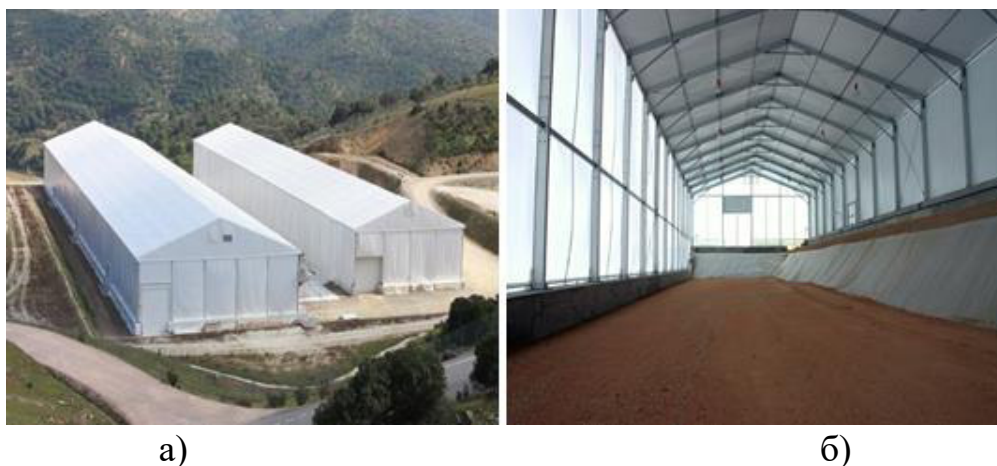
Рисунок 1.11 - Сооружения для очень низкоактивных радиоактивных отходов: а) вид сверху, б) вид изнутри [21, 22].
