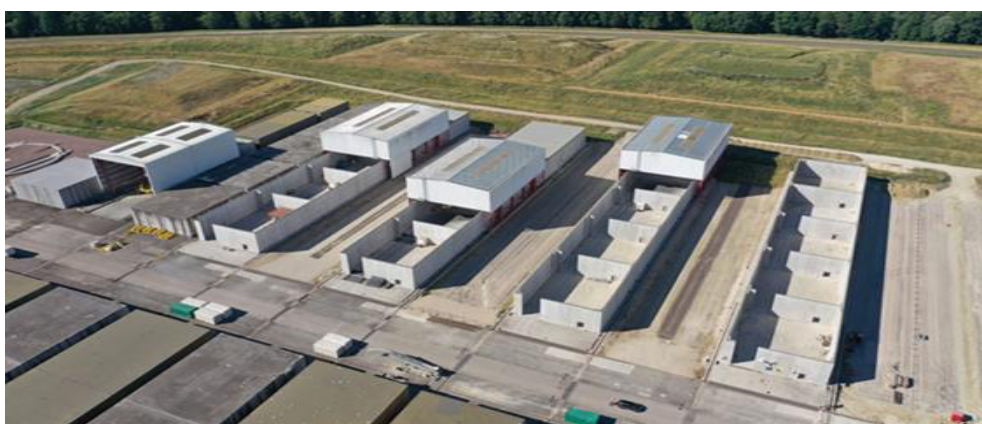
Рисунок 1.8 – Модульные сооружения: законсервированные секции, секциями с защитной мобильной крышей, секции, подготовленные к заполнению [16].
